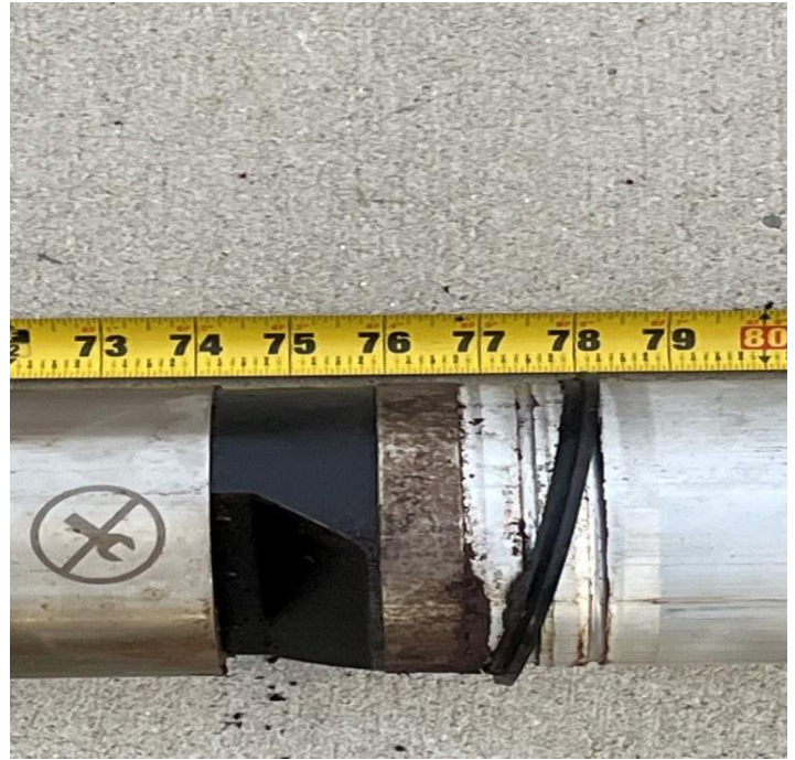
DSL OVERFILL EQUIP TEST
