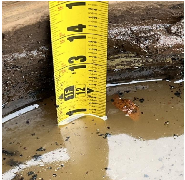
DSL SPILL BUCKET TEST END 13"
